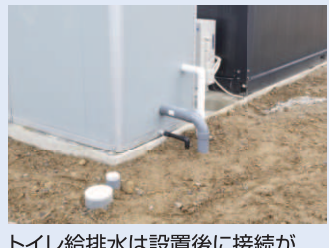
トイレ給排水は設置後に接続が 可能な壁からの横出し式です。
