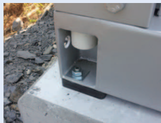
OD-54 アンカー打込み例 M12アンカーボルト
