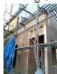
これで地震・台風はんで怖くない!
