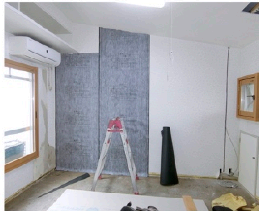
北西洋室遮音シート貼
