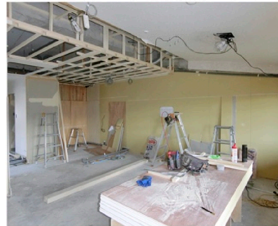
リビング天井下地
