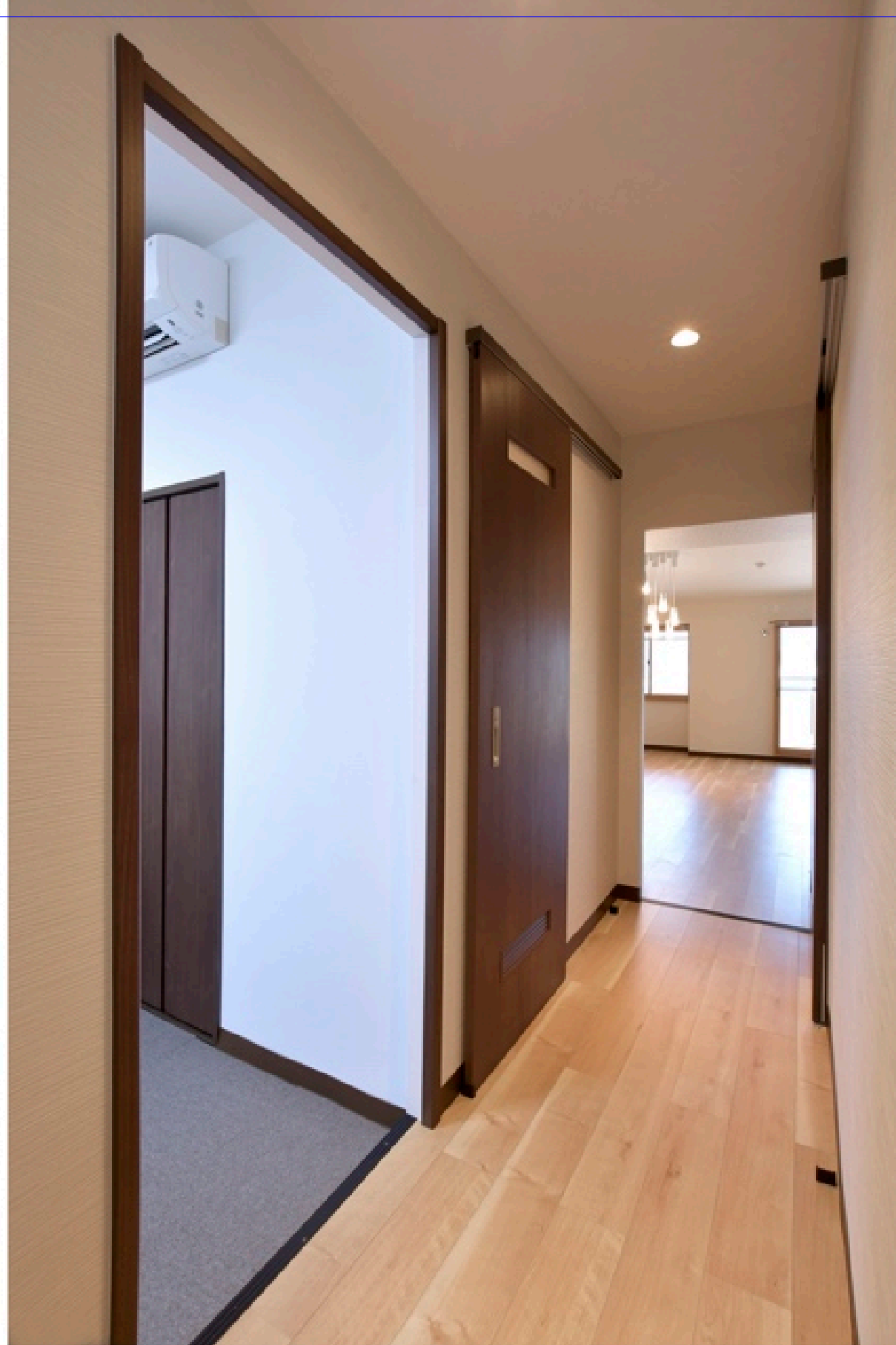
玄関より廊下 各室出入口は全て引き戸に
