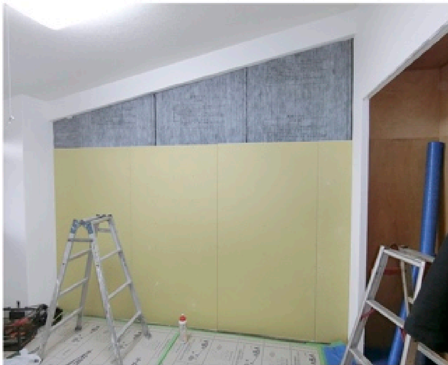
北西洋室遮音ボード貼
