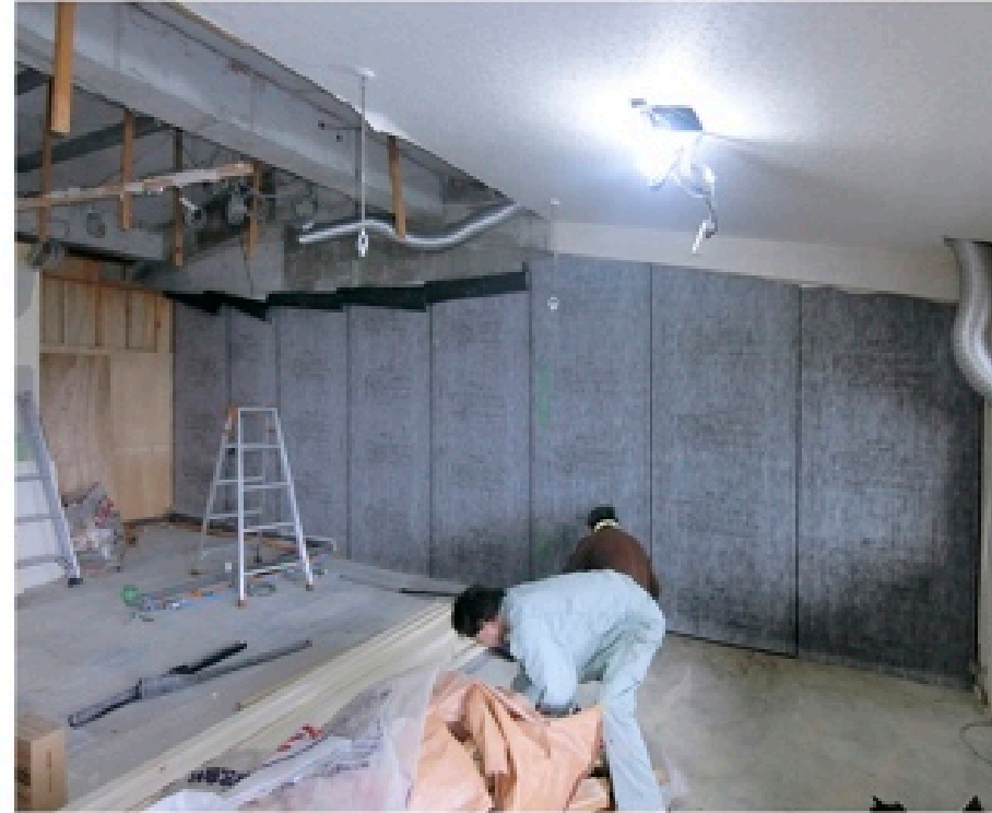
リビング遮音シート貼
