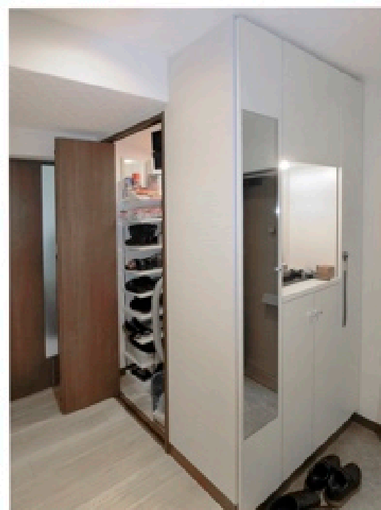
既存下駄箱を再利用、扉は開きから折れ戸に
