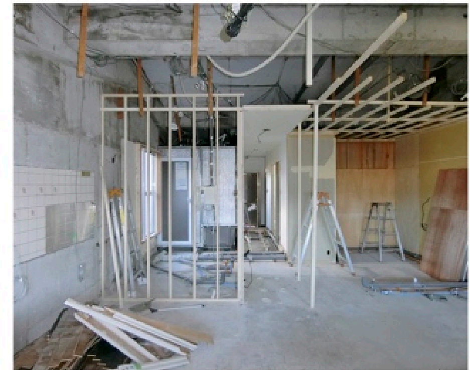
間仕切り工事
