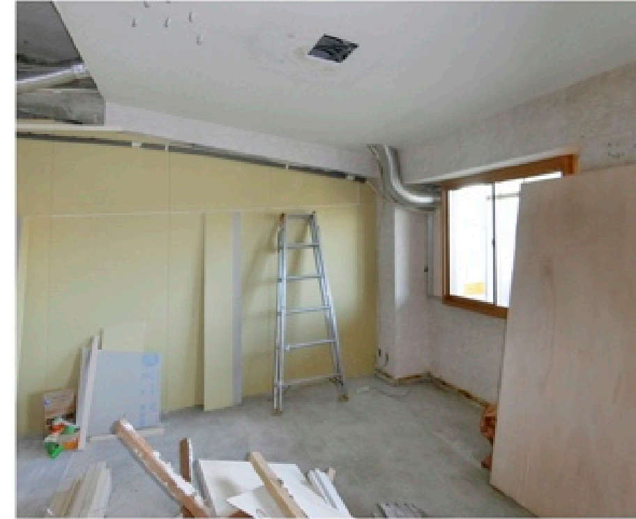
リビングボード貼と排気工事
