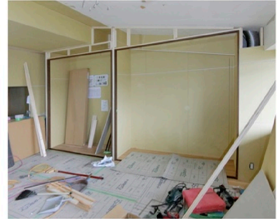
リビング収納工事
