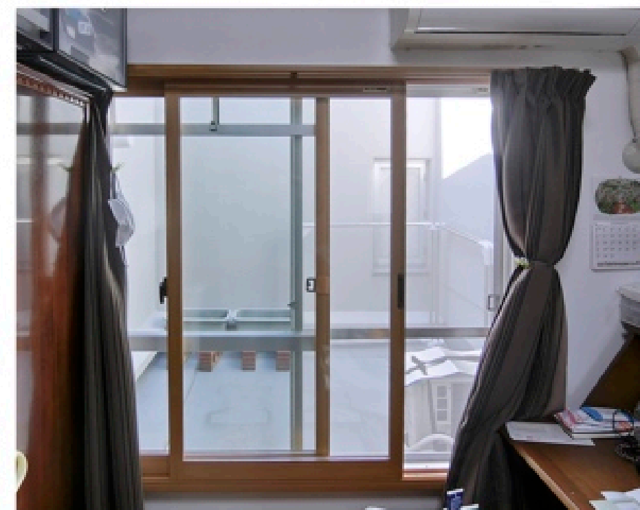
北西洋室二重サッシュ取付
