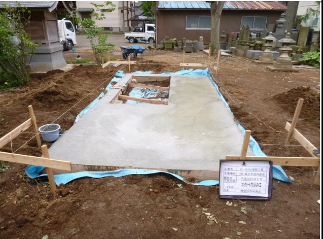
コンクリート打込工
