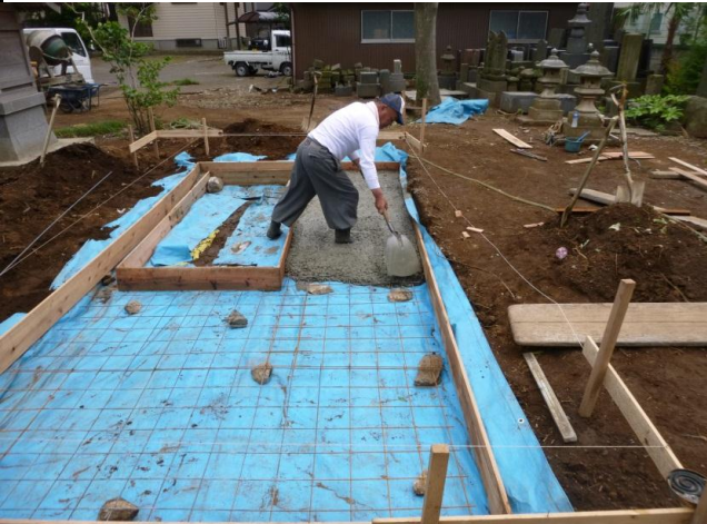
コンクリート打設準備
