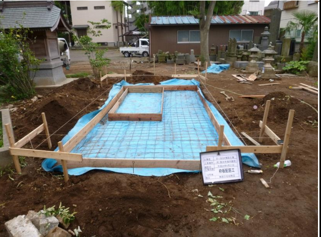
コンクリート打設準備
