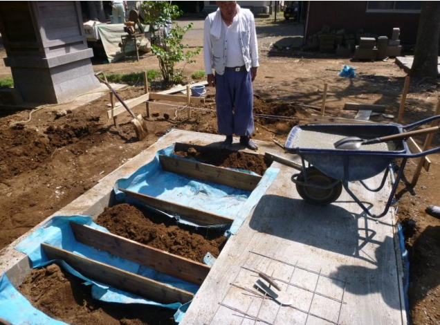
コンクリート打込工
