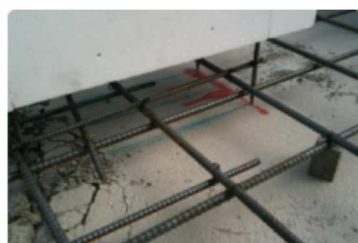
浮かし型枠でコンクリートの1回打ちが可能
